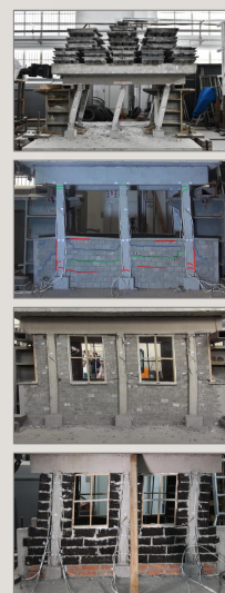
试验模型损伤状态
