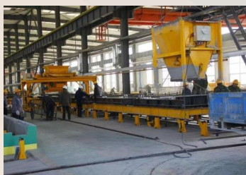
预制构件厂生产车间
