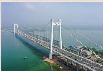
河北官厅水库特大桥
