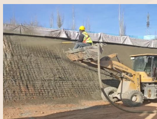
边坡挂网喷浆
