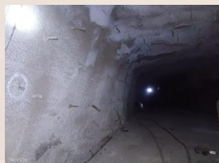
煤矿井下巷道喷浆
