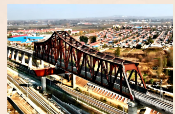
潍莱铁路特大桥
