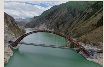
川藏铁路藏木特大桥
