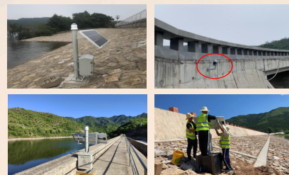
土石坝、混凝土坝、闸坝、堤防等应用
