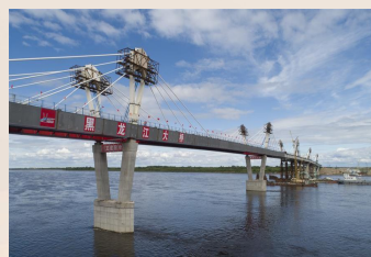
中俄黑河特大桥
