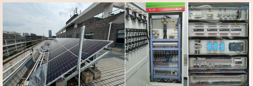
水冷式PV/T热泵热电联供系统
