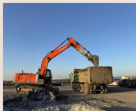
全固废工程土
