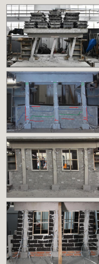
试验模型损伤状态
