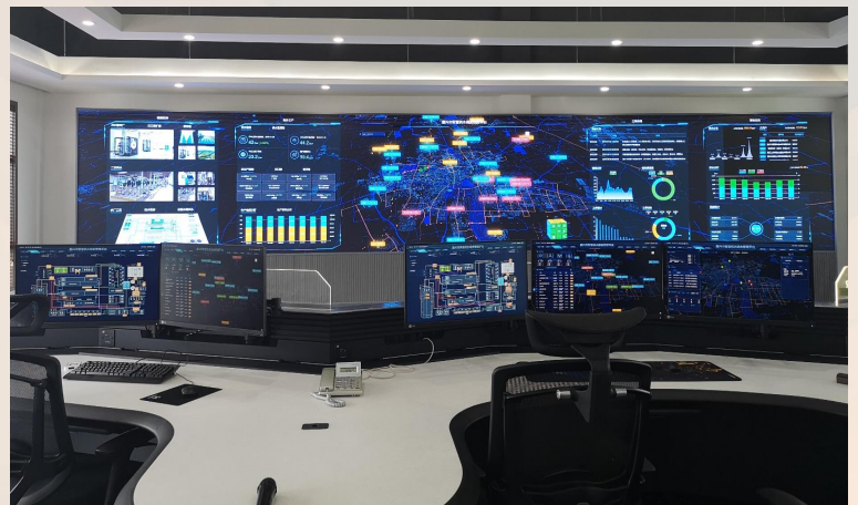
嘉兴城乡一体供水管网智能管控平台
