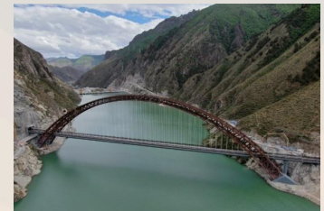
川藏铁路藏木特大桥
