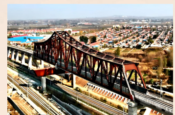
潍莱铁路特大桥
