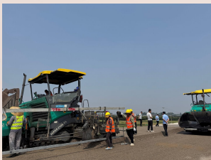
固废基半刚性基层
