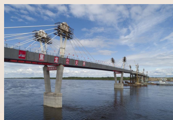
中俄黑河特大桥
