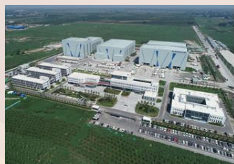
容西混凝土搅拌站项目
