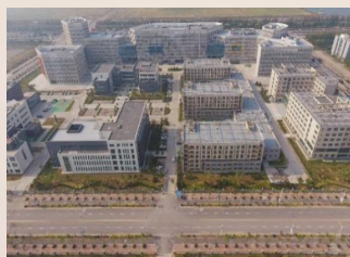
曹妃甸钢铁电力中心
