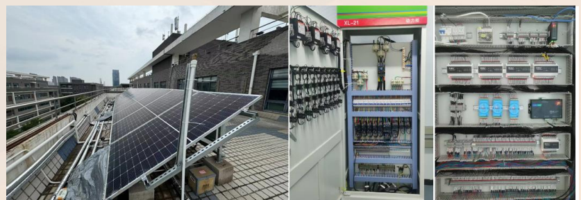
水冷式PV/T热泵热电联供系统
