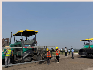
固废基半刚性基层
