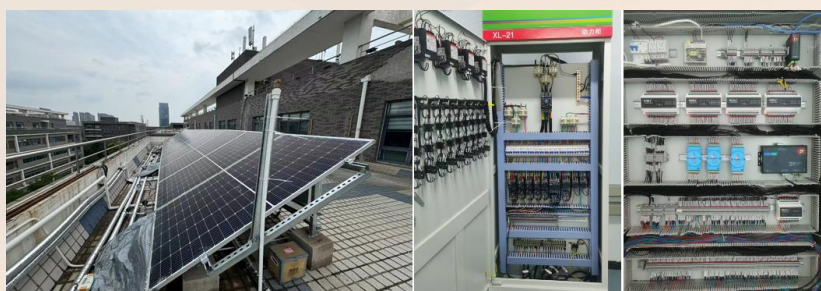
水冷式PV/T热泵热电联供系统
