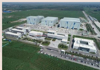
容西混凝土搅拌站项目
