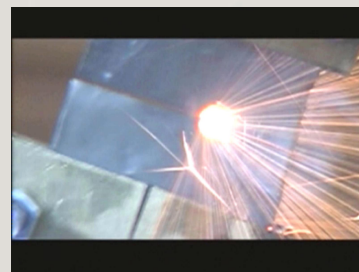
放电止裂喷射状态
