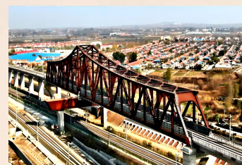
潍莱铁路特大桥
