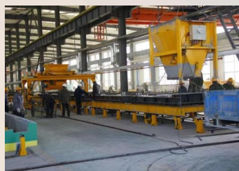
预制构件厂生产车间
