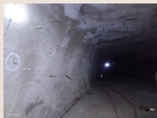
煤矿井下巷道喷浆
