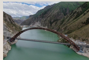
川藏铁路藏木特大桥
