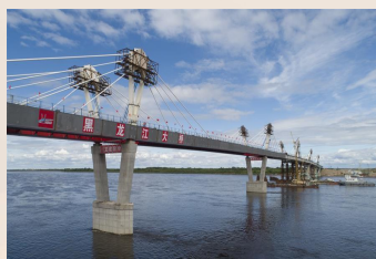
中俄黑河特大桥
