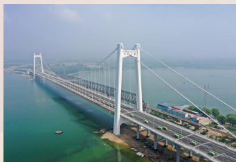
河北官厅水库特大桥
