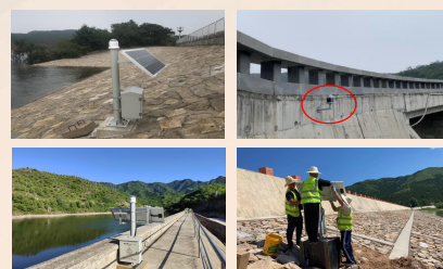
土石坝、混凝土坝、闸坝、堤防等应用
